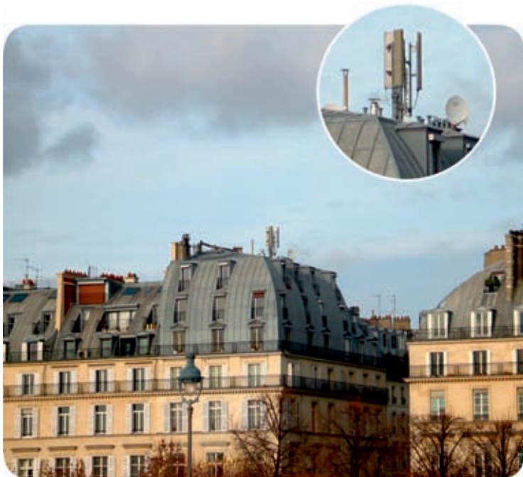
Paris, Luvru, Rue de Rivoli colț cu Rue de St. Roch
